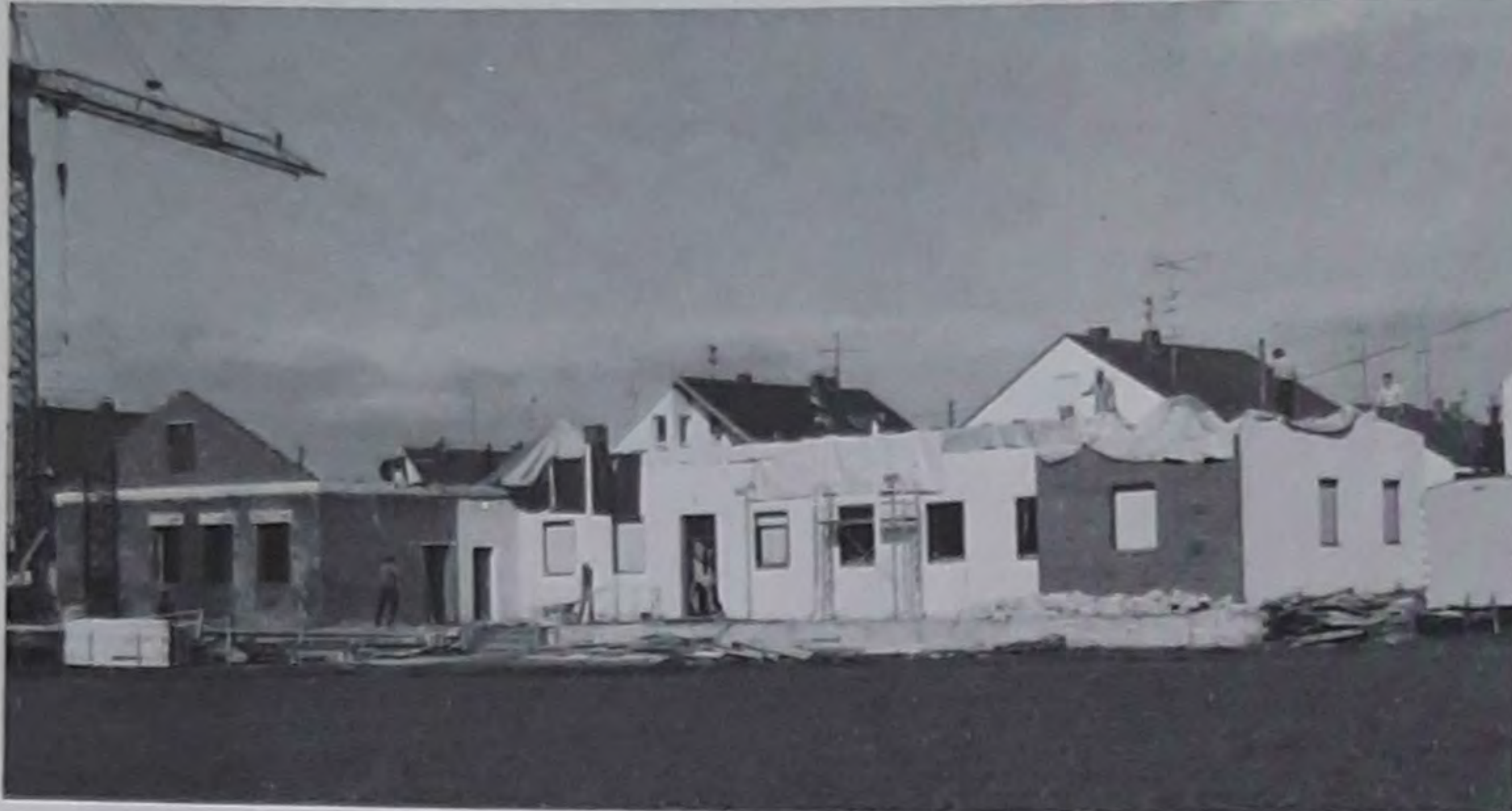
„Großbaustelle“ Vereinsheim mit den neuen Anbauten
